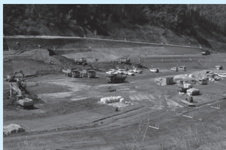
最終処分場建設地
