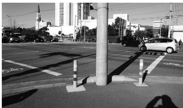
安全対策のために設置されたポール
