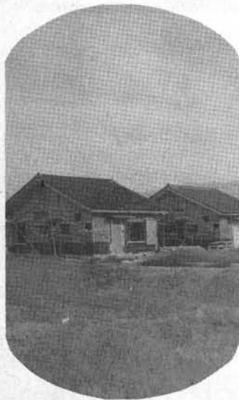
工事中の常水分譲団地
