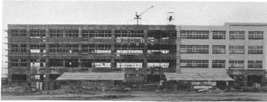
建築中の新校舎
