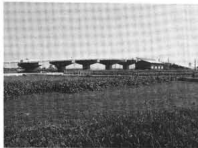
完成間近、医大取付道
