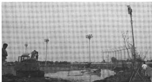
急ピッチで行なわれる夜間照明工事 (中学校々庭)
