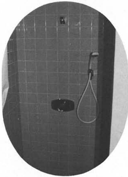
管理棟シャワー室
