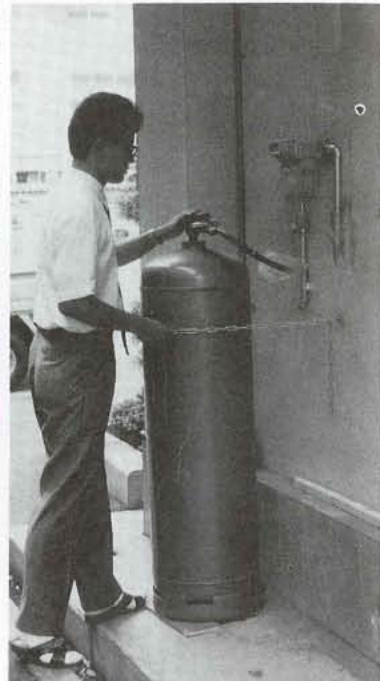
▲プロパンガスのボンベなどは鎖でしっかり固定を!!
