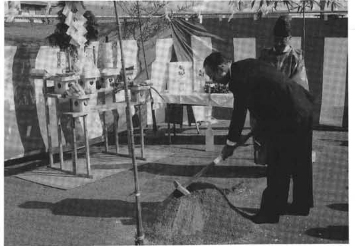
▲昭和66年度完成を目指して工事着工。
