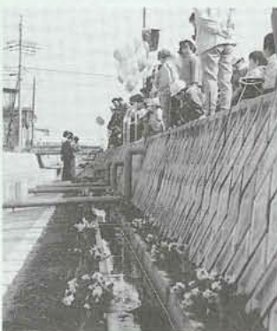
▶新しく造られた常永川人工水路
