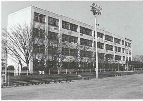
▲ 生徒数の増加による増築工事が(押原中)
