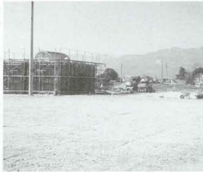
▲ 急ピッチで工事が進む常永公園
