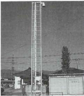
▲新設された消防ホース乾燥塔
