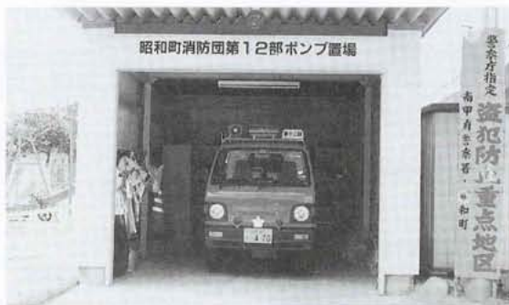
▲新しくなった上河東二区消防ポンプ小屋
