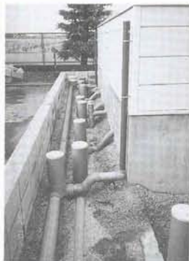
▶ 地中に埋められる汚水ます
