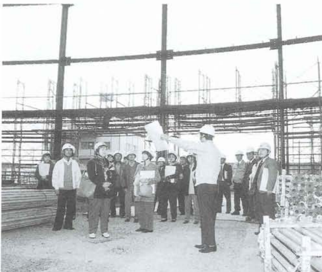
▲平成9年完成を目指し工事の進む町民体育館。 町政モニターのみなさんが、工事現場を見学しました。
