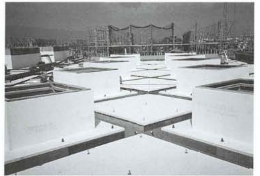
ランチルーム付近の屋根の工事状況
