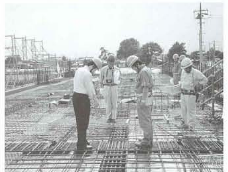
2階床の配筋検査の状況
