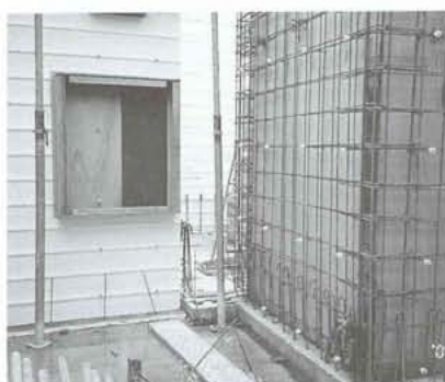
壁の鉄筋、配管、型枠(化粧)の状況
