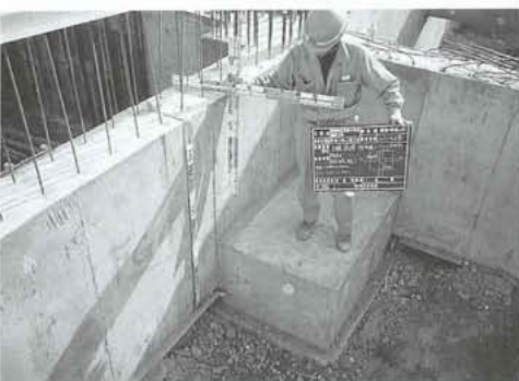
基礎、柱、地中梁の状況
