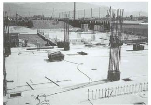
A棟 D1棟の1階床コンクリート状況
