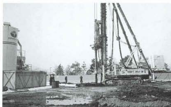
改良杭施工状況
