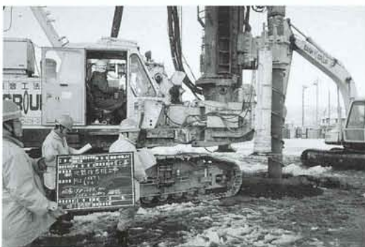
監理者立会いによる1本目の施工
