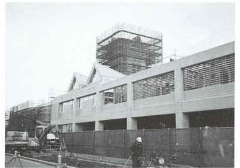
足場を撤去した校舎北面の様子（児童館側）
