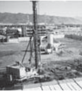
▲ソイルセメントコラム工法施工状況
