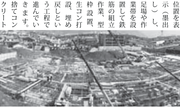
▲校舎の建設現場の状況（3月中旬）
