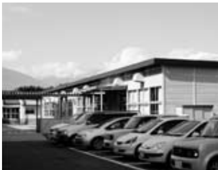
西条小学校増築校舎建設予定地
