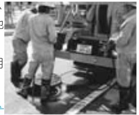
▲マンホール清掃の様子
