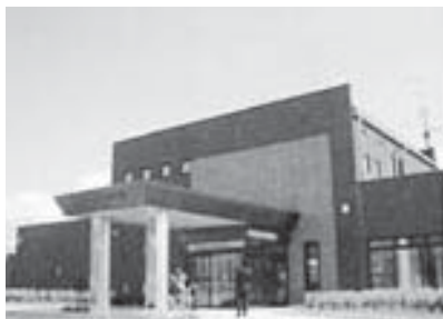
押原公園管理棟(H18年度建設済み)
