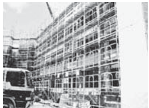
第1期工事中の町営住宅
