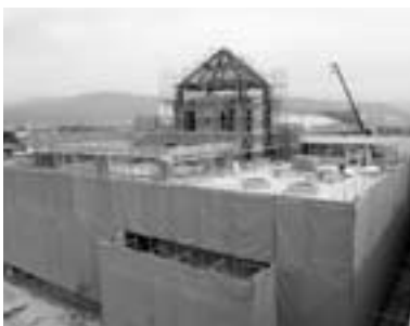
西条小学校増築工事
