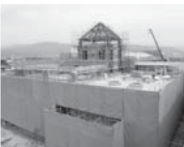
西条小学校増築工事
