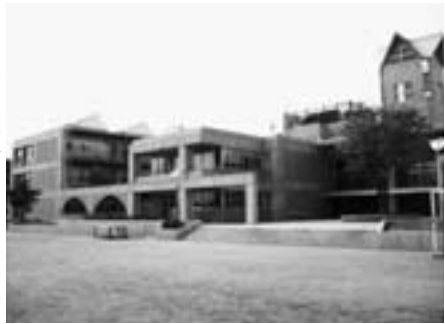
東側から校舎を望む
