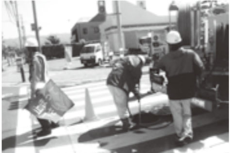
▲マンホール清掃の様子
