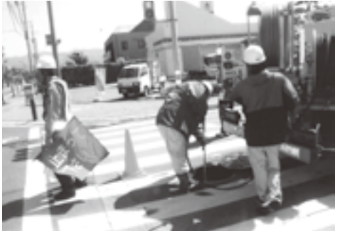
▲マンホール清掃の様子
