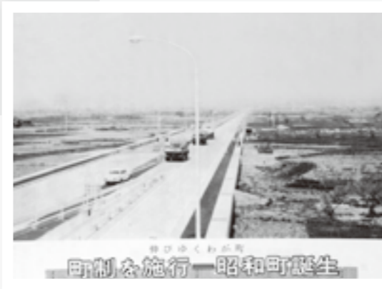
▲昭和46年4月号の表紙(建設中の国道20号)
