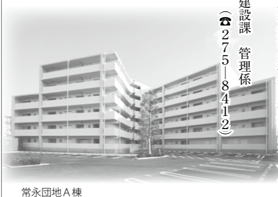
常永団地A棟
