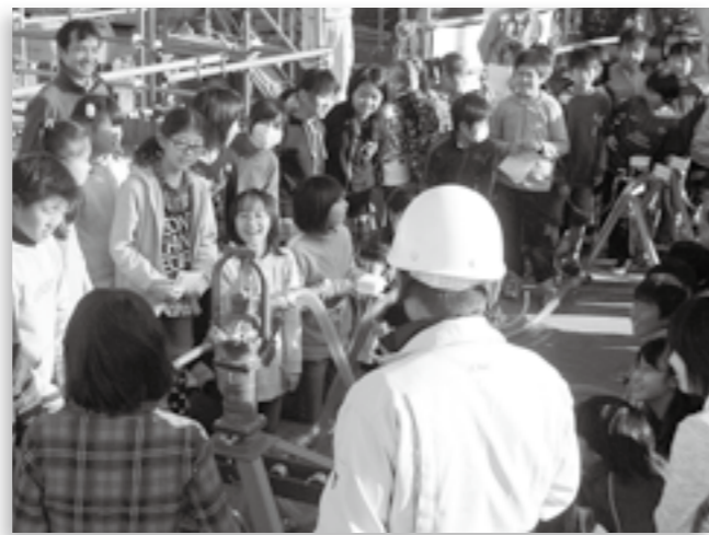
▲耐震性貯水槽とポンプを見学する子どもたち
