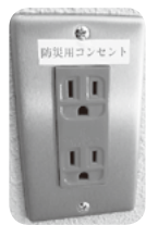
停電時にも電気を使う非常用コンセント(赤色のコンセント)
