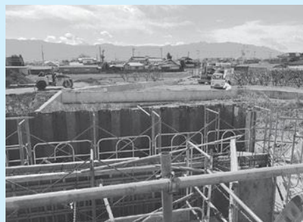
町道30号線工事箇所
