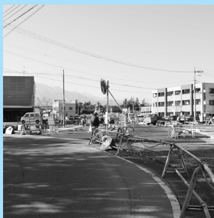
工事が進む西条・昭和インター線
