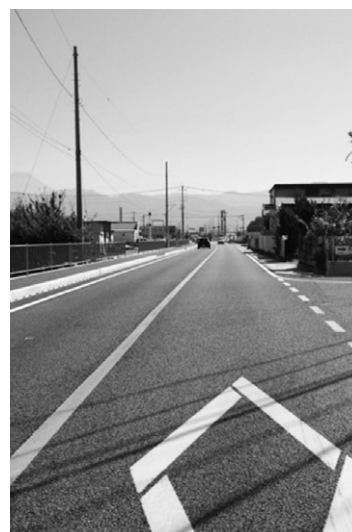
新甲斐中央線（築地新居地内）
