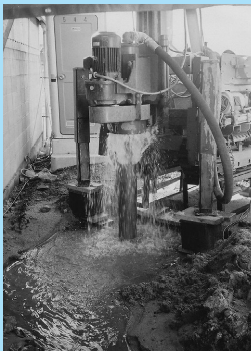
井戸掘削工事の様子
