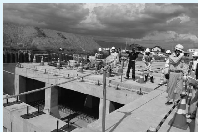
建設中の調整池
