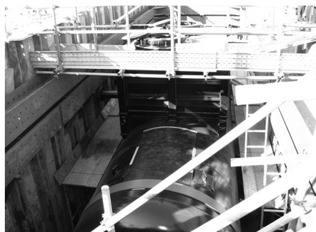
常永小に続き設置される貯水槽
