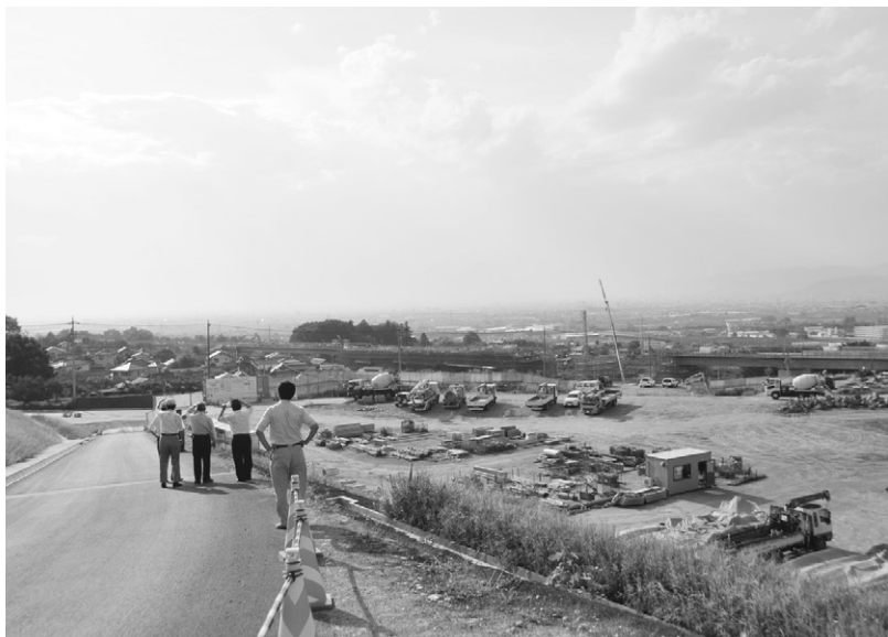
リニア境川工事現場（産業土木常任委員会）
