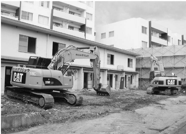
町内の工事現場
