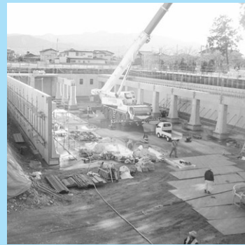
工事中の3号調整池
