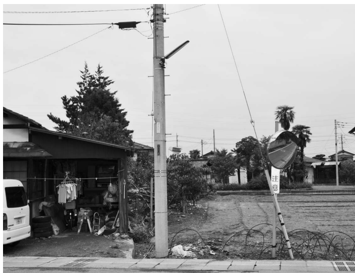
区で管理されている防犯街路灯
