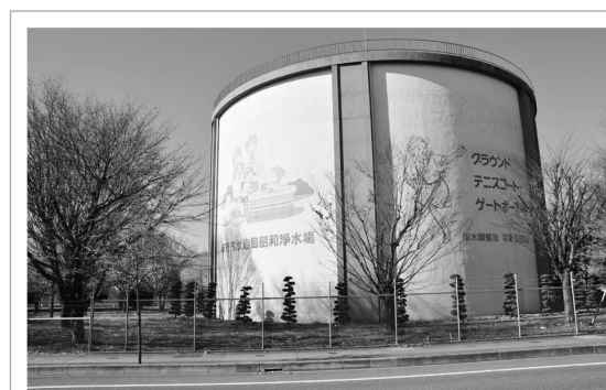
甲府市水道局昭和浄水場
