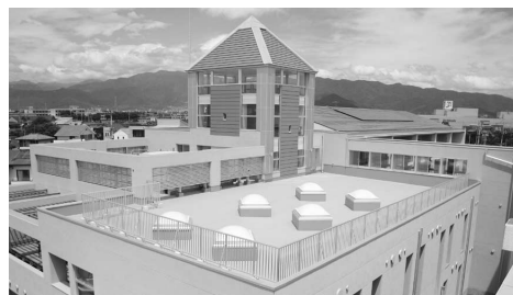
西条小の屋上には ソーラー設備
