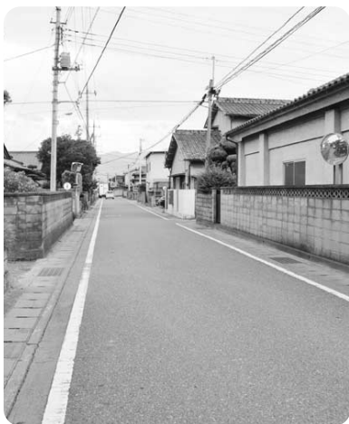
下水道が望まれる幹線道路 (町道6号線)
