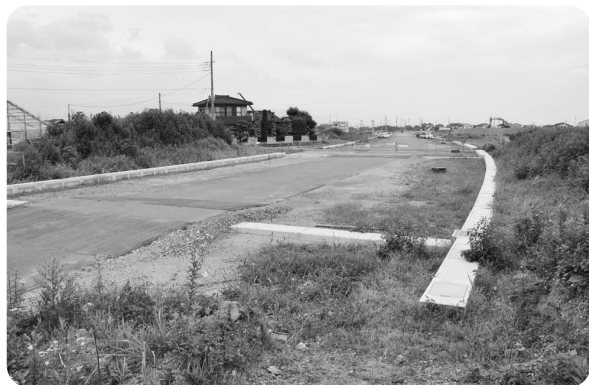
工事中の幹線道路
