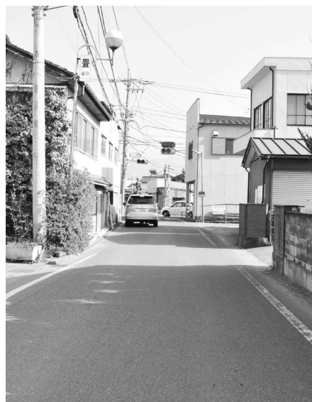
拡幅および安全対策が望まれる道路 (国母駅入口交差点)
