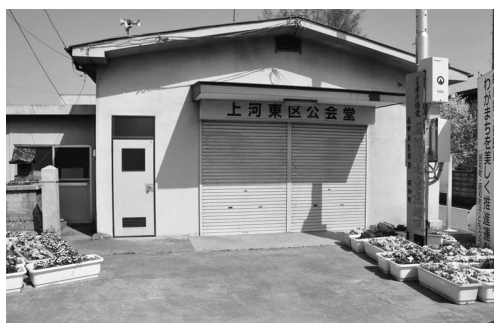
建て替えが検討されている 上河東公会堂
