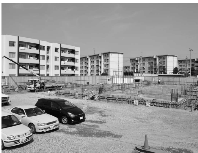
町営住宅南棟第2期建設工事(3月末撮影)
