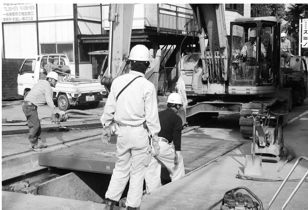
下水道工事中の築地新居区
