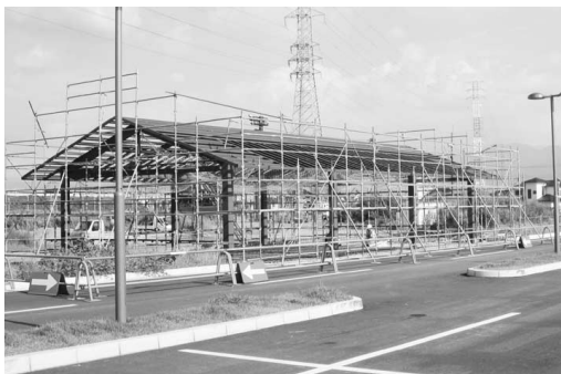
押原公園に建設中の防災用備蓄倉庫
