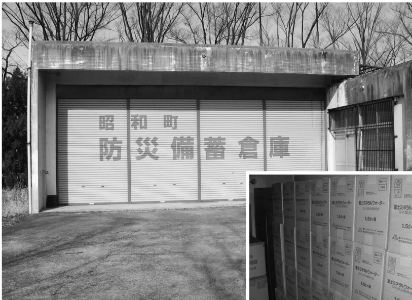
国母工業団地内にある防災備蓄倉庫と備蓄飲料水
