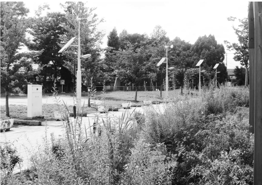
押原小学校に設置されている風力発電
