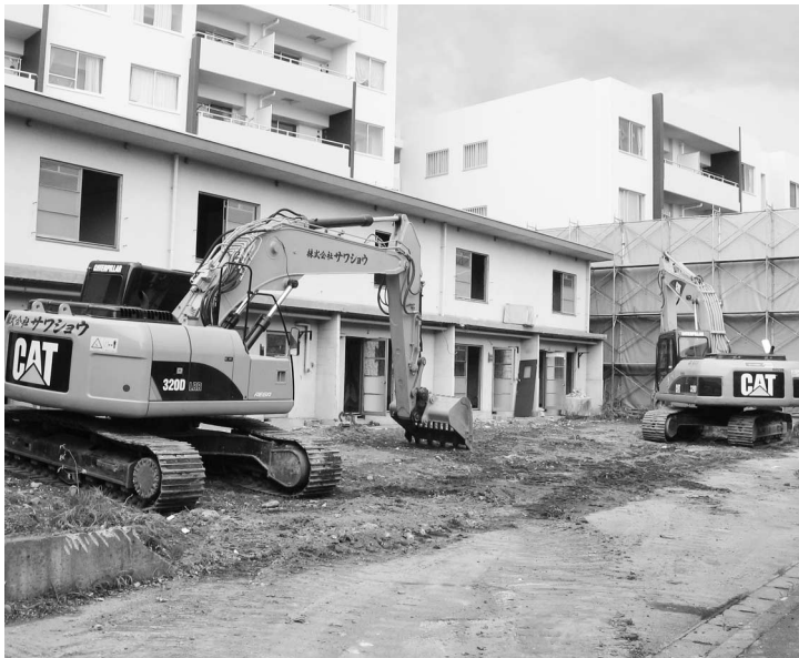
町営住宅解体撤去工事現場
