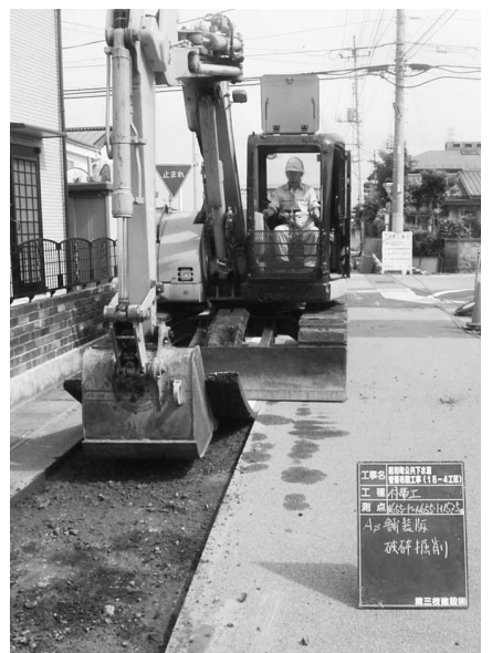
計画的に整備される下水道工事
