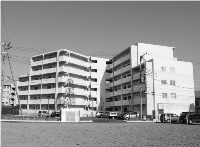
町営常永団地第一期工事完成
