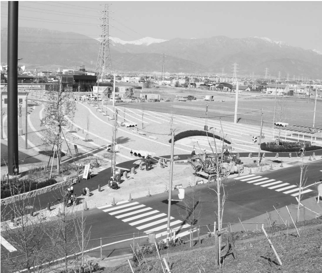
急ピッチで進む押原公園の整備
