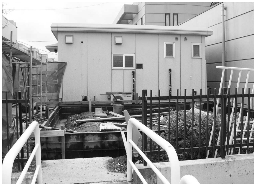
整備中の昭和町ボランティアセンター
