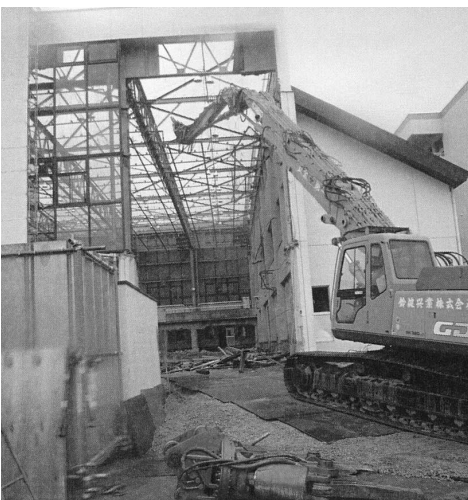
取り壊される町民体育館
