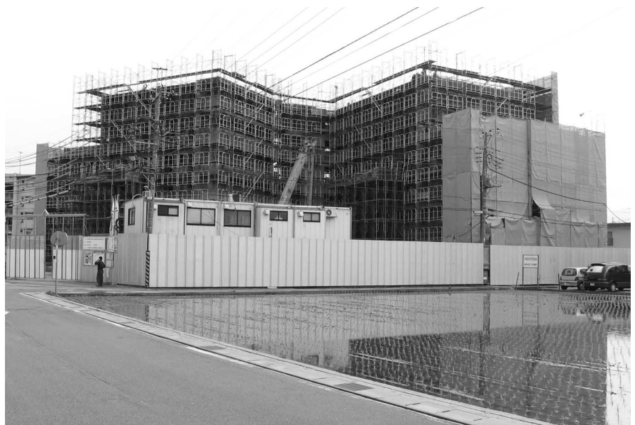
着々と進む第一期工事
